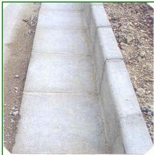
Foto cordolo cunetta alla francese
